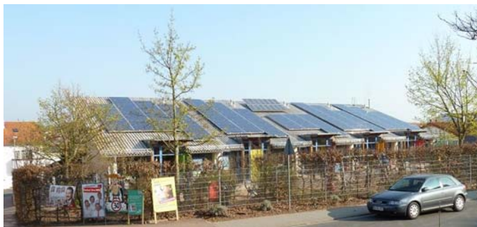
PV-Anlage Kindergarten Thüringer Straße: Unten spielt die zukünftige Generation und Oben wird ihre Zukunft gesichert – ein gelungenes Konzept.
